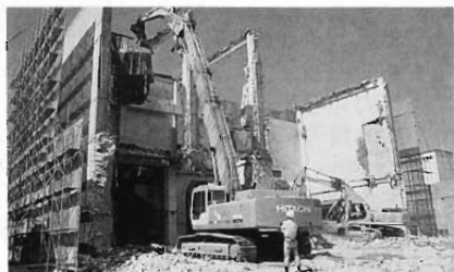
写真1 解体中のタービン建屋
